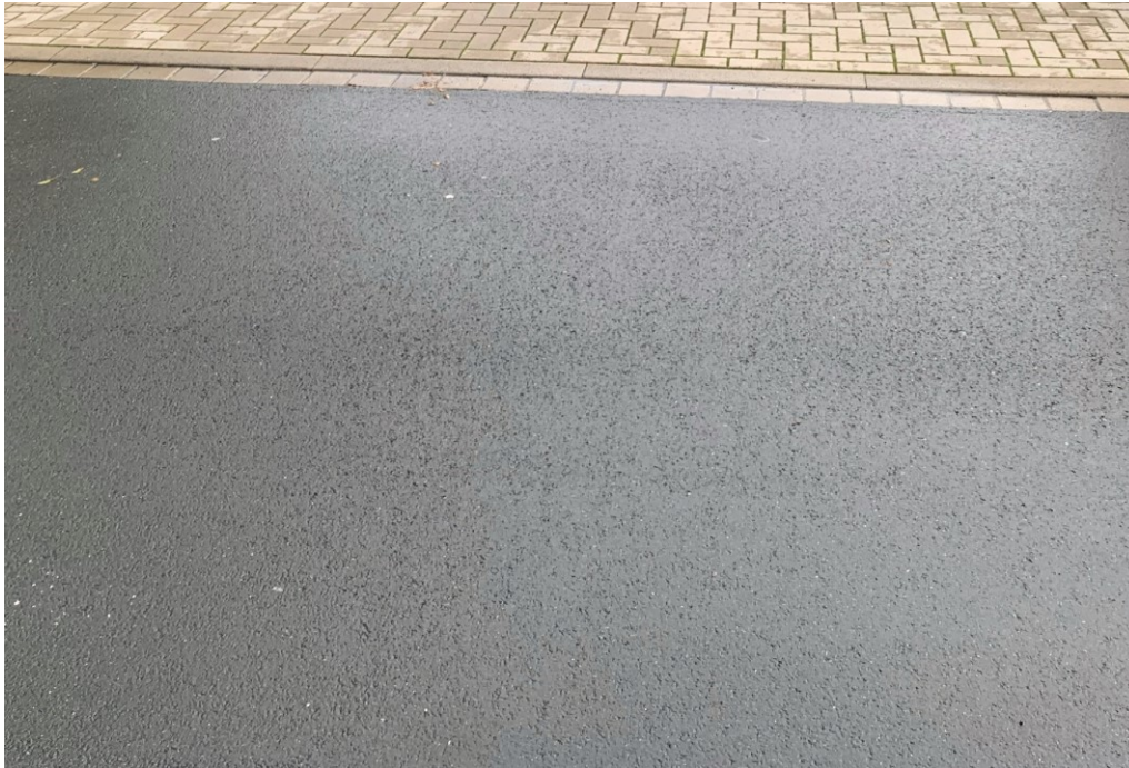
Abb. 17: Beispiele Themenkreis Material und Oberfläche – Asphalt
