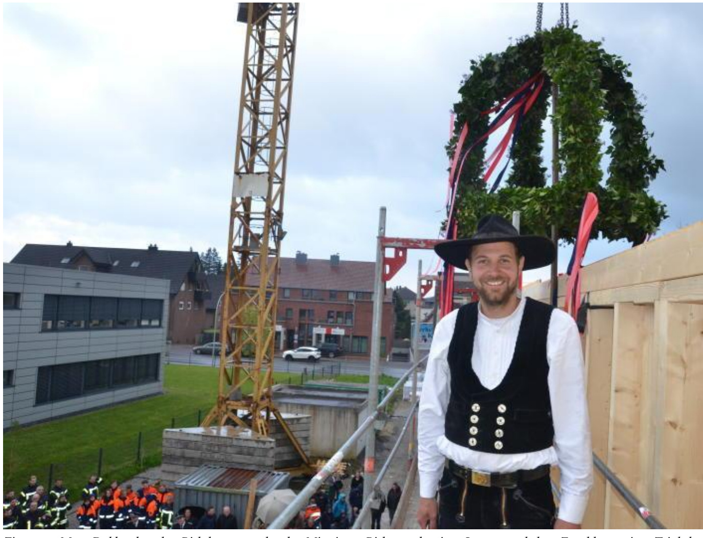
Zimmerer Marc Dübber hat den Richtkranz angebracht. Mit einem Richtspruch seiner Innung und dem Zerschlagen eines Trinkglases wünscht er dem Bauherrn viel Glück.
