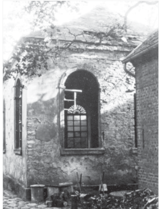
Die zerstörte Synagoge um 1950 (Foto: K. W. Weinberg)
