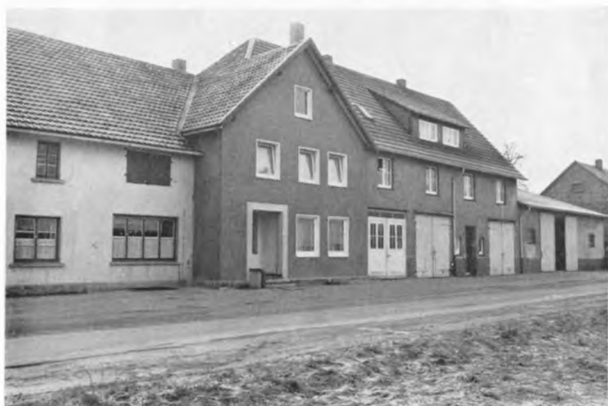
Der Mitteltrakt des heutigen Bürogebäudes stellt die von Großvater Bültmann 1890 erbaute Keimzelle des Unternehmens dar.
