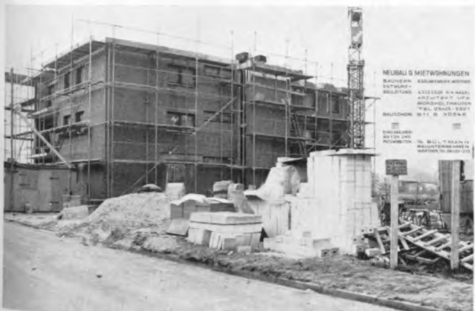
Das zur Zeit im Bau befindliche Neun-Familienhaus Grünkemeier
