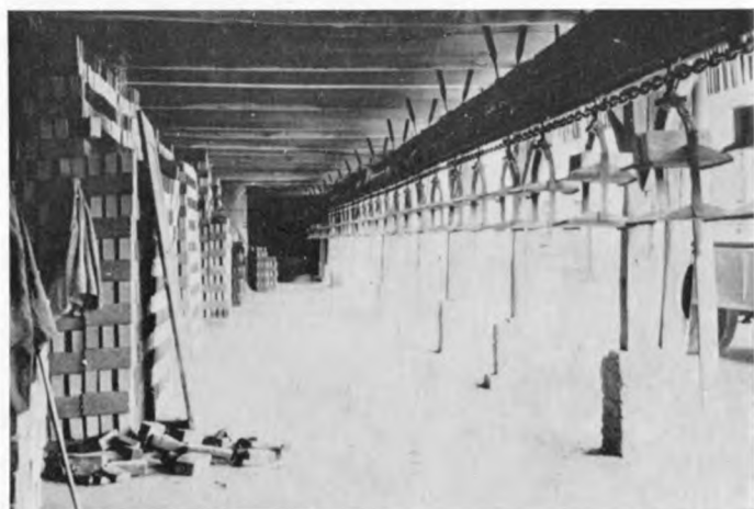
Transport der Rohlinge durch den 750 m langen Ring-Transporteur
