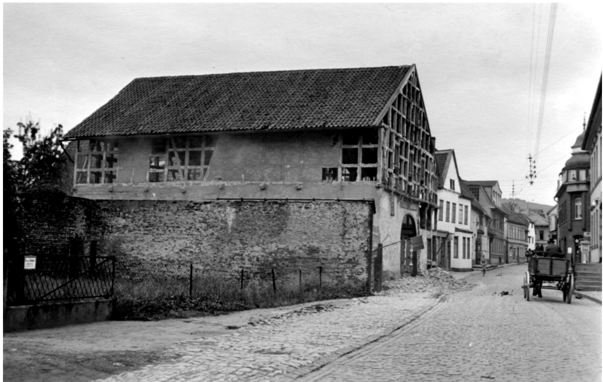
Ravensberger Str. 18 beim Abbruch
