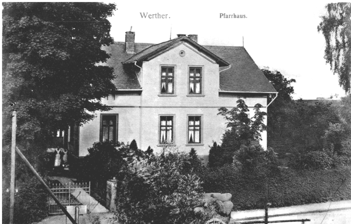
Alte Bielefelder Straße, Pfarrhaus
