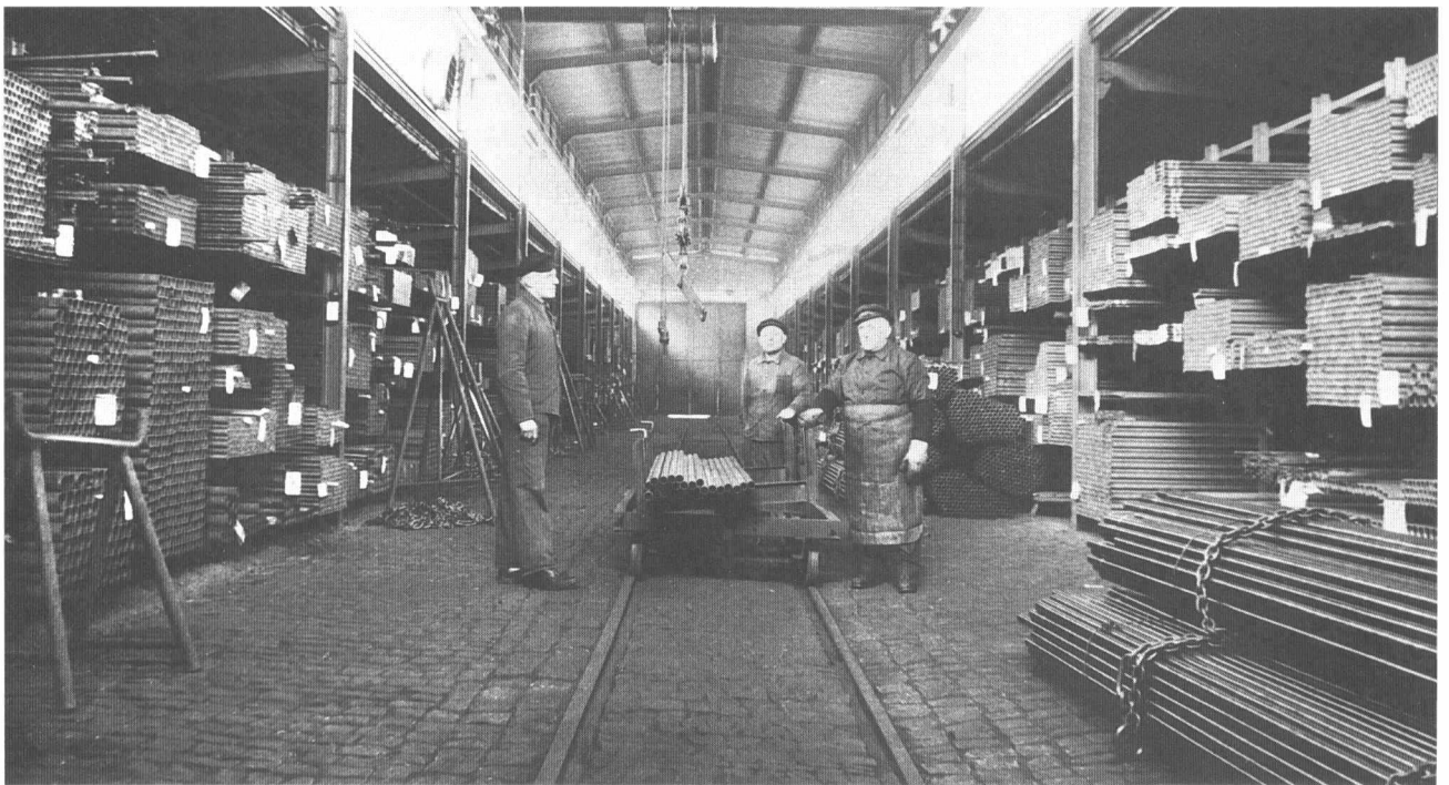
Rohrlager im Jahre 1961 (Firmenfoto)
