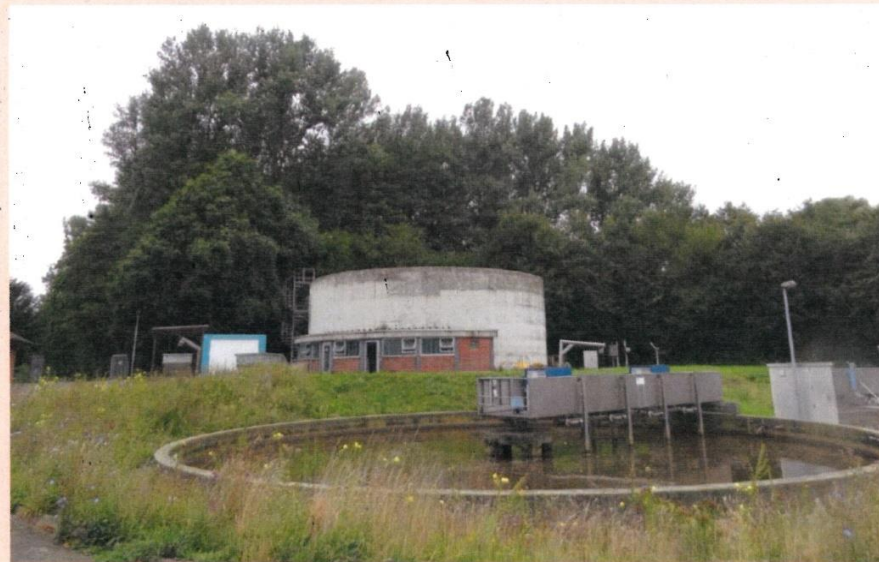
Die alte Anlage wird vollständig umstrukturiert und erneuert
