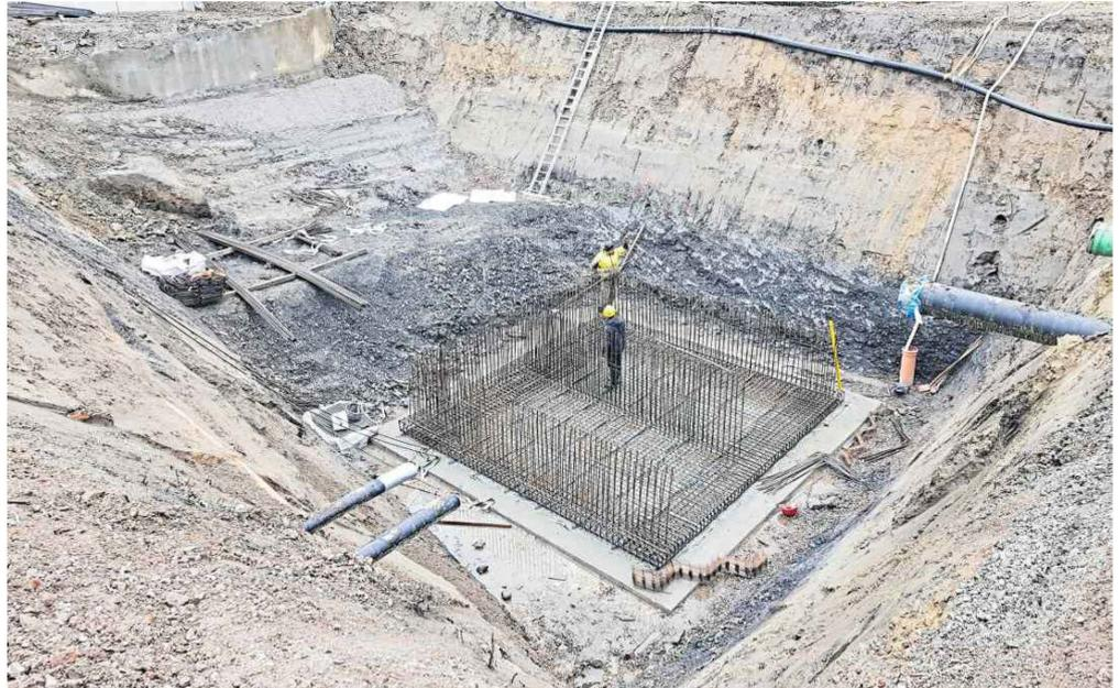
Sieben Meter tief ist die Baugrube, in der demnächst das Herzstück der Kläranlage eingebaut wird. Um dann Gefahrstoffe aus den Abwässern filtern zu können, die im Schwarzbach definitiv nichts zu suchen haben.
