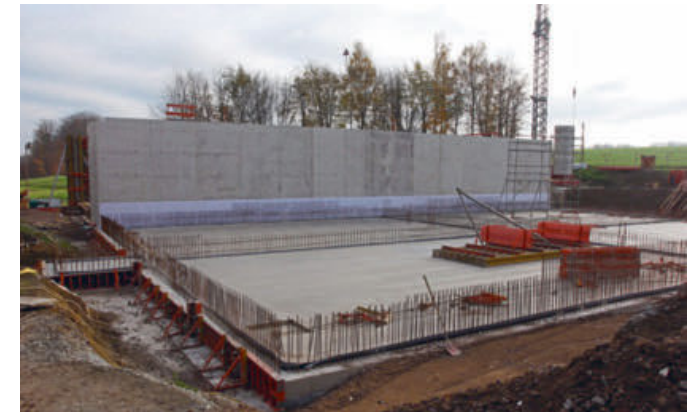
Beim vorderen der beiden künftigen Klärbecken liegt bislang nur die Betonsohle und ragen die Stahlbewehrungen für die Wände heraus. Dahinter geht es schön kräftig in die Höhe.
