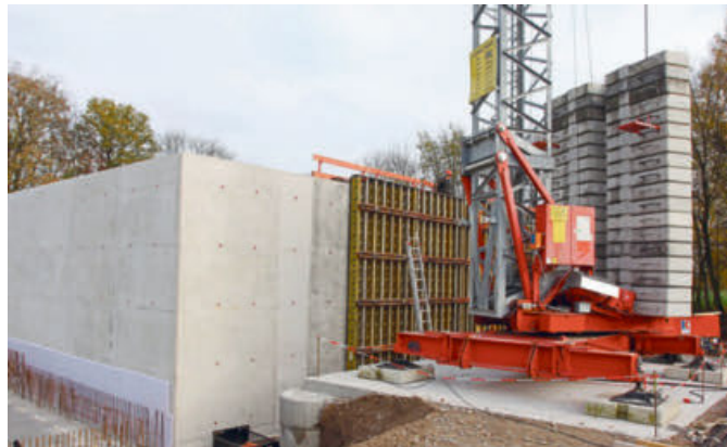
Die ersten Wände der künftigen rechteckigen Klärbecken sind bereits betoniert. Kaum sind die Mauern ausgetrocknet, wird schon mit der Verschalung des nächsten Abschnittes begonnen.
