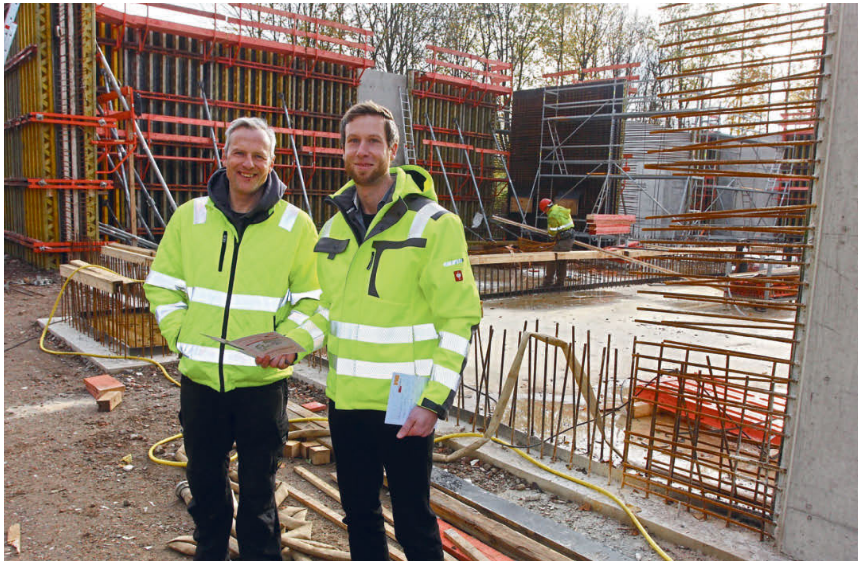
Klärrmeister Guido Wemhöner (links) und Projektleiter Alexander Schweitzer strahlen angesichts des zügigen Baufortschritts. Die Sohlen für beide Klärbecken sind gegossen, einige Wände stehen schon oder werden gerade verschalt.
