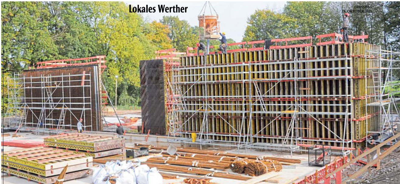
Die Betonmischer geben sich die Klinke in die Hand: Unter Hochdruck wird in diesen Tagen auf dem Kläranlagengelände an der Siegfriedstraße gearbeitet, um das gute Wetter auszunutzen. Unser Foto zeigt die Arbeiter an den zwei riesigen Betonbecken, in denen künftig die biologische Reinigung der Abwässer stattfinden wird. Foto: Anja Hanneforth
