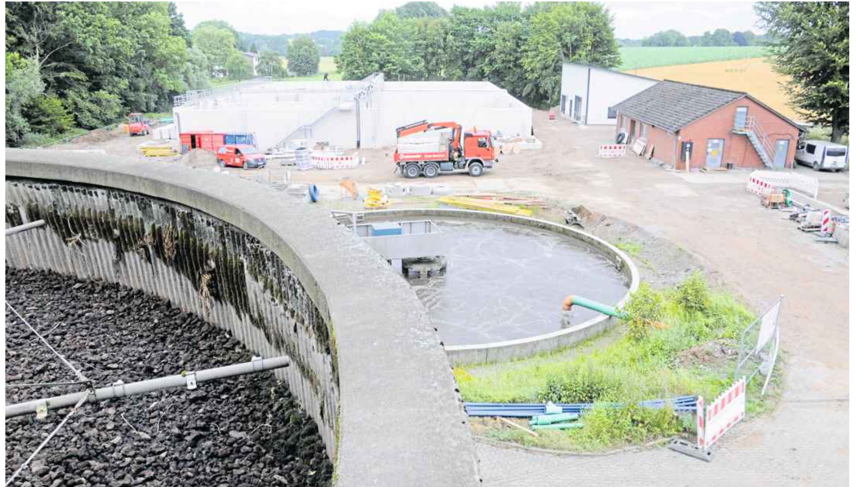
Die größte Baustelle der Stadt liegt derzeit an der Siegfriedstraße. Hier entsteht für zehn Millionen Euro die neue Zentralkläranlage von Werther. Die acht Becken der biologischen Reinigung (hinten Mitte) und die Schlammwässerungshalle (rechts hinten) sind annähernd fertig, das derzeitige Betriebsgebäude (rechts) wird zur Werkstatt umgebaut. Das aktuelle Belebungsbecken (Mitte) bleibt als Havariebecken erhalten, der Tropfkörper vorn ist hingegen abgeschaltet und wird in den nächsten Tagen abgerissen. An dessen Stelle wird später das neue Betriebsgebäude errichtet. Fotos: Anja Hanneforth
